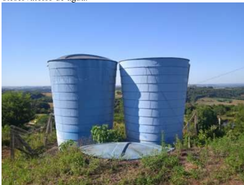
Figura 26: Reservatório de água.
