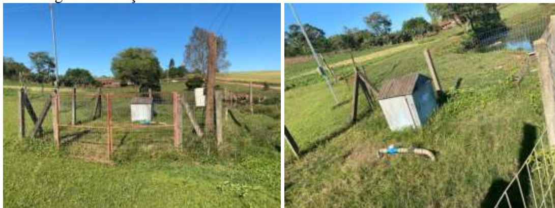
Figura 27: Poço Artesiano da Linha Bom Retiro.
