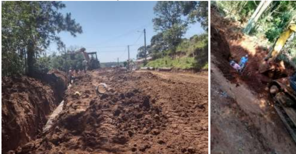
Figura 80: Troca e manutenção de bueiros.
