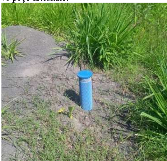
Figura 35: Novo poço artesiano.
