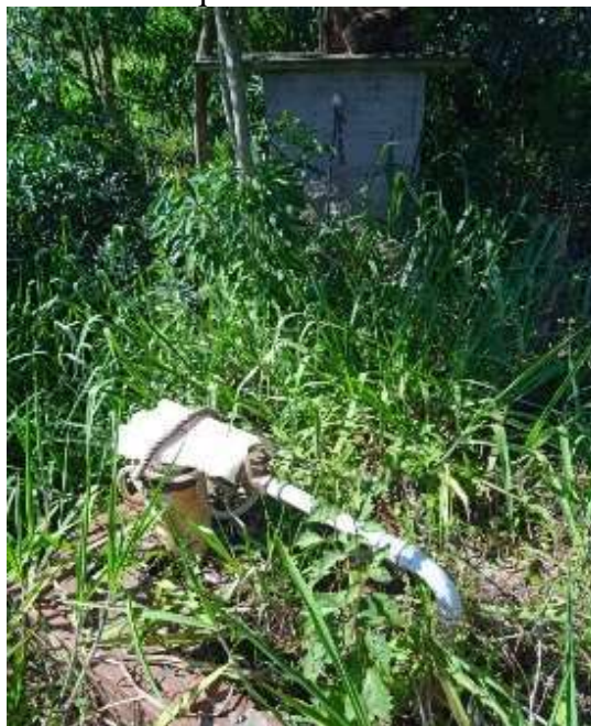
Figura 33: Poço artesiano Esquina Gaúcha.
