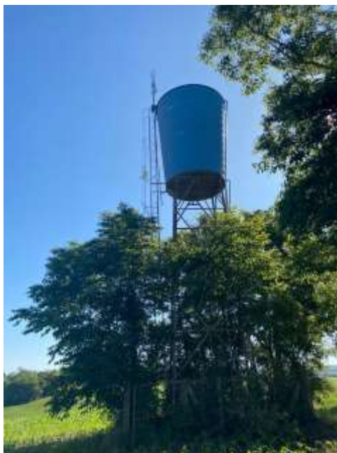
Figura 28: Reservatório Elevado de Bom Retiro.
