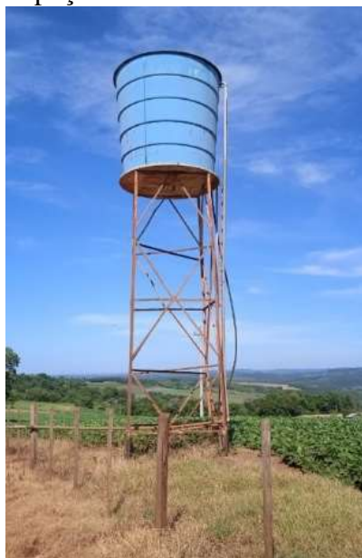
Figura 24: Reservatório do poço de Alvorada.
