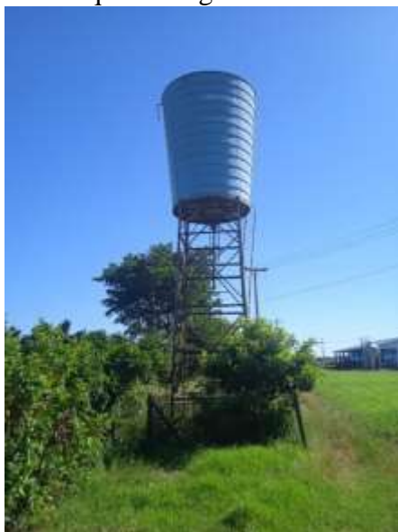
Figura 37: Reservatório Esquina Progresso.
