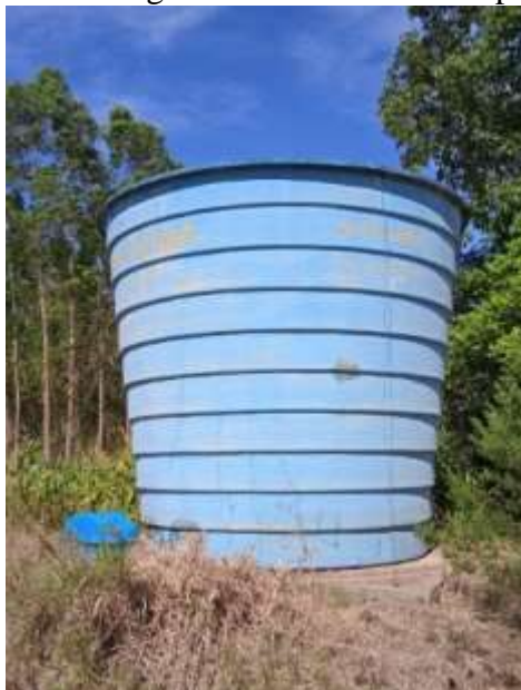
Figura 55: Reservatório de água em Ressaca do Campo Sales.
