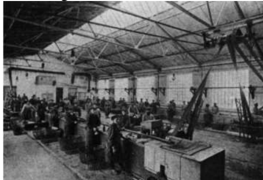
Figura 60: Galpão de triagem de resíduos em 1910 München na Alemanha.
