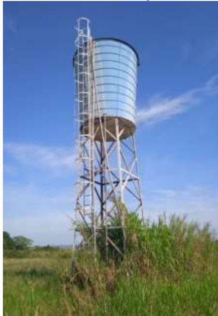
Figura 43: Reservatório da Linha Alto Caçador.
