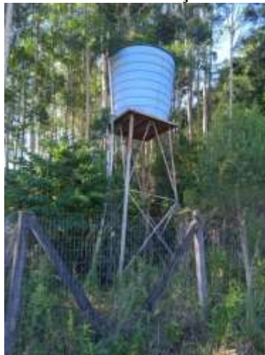
Figura 22: Reservatório da Linha Alto Caçador.
