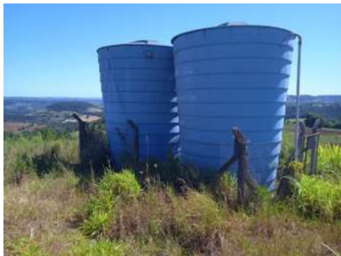
Figura 49: Reservatório da localidade de Passa Três.
