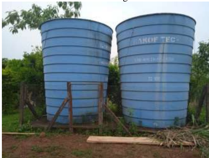
Figura 30: Reservatório do Distrito Alto Uruguai.
