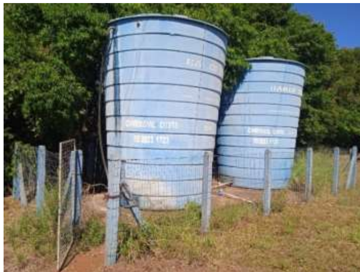
Figura 53: Reservatório da localidade de São João.
