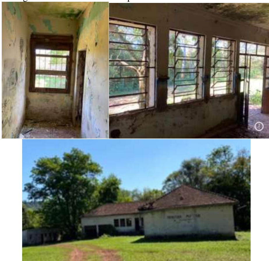
Figura 16: Área da marinha e prédio existente.
