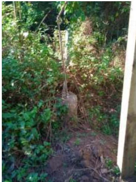
Figura 25: Poço artesiano de Barrinha.
