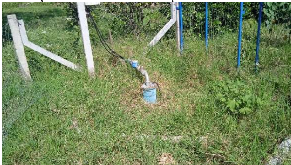
Figura 54: Poço artesiano em Ressaca do Campo Sales.
