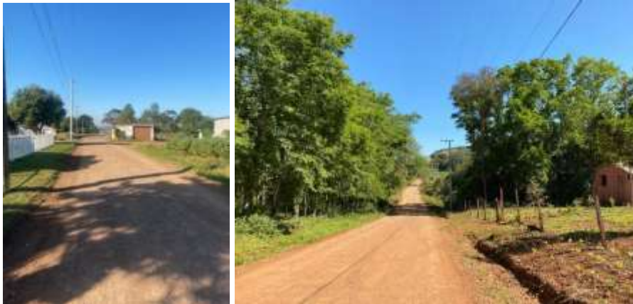
Figura 79: Drenagem das vias de acesso do interior.
